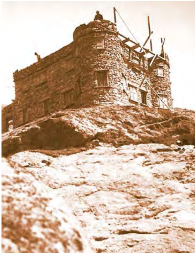
Bild: Siegerlandhütte im Bau, 1928 (Archiv)
